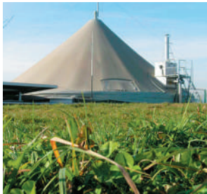
Рис. 6.6. Установа для отримання біогазу завдяки метаногенним археям
