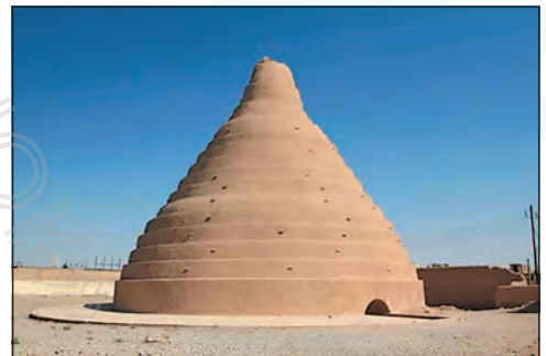
Якхчаль — башта для зберігання продуктів у спекотному кліматі, яку придумали в Давній Персії. Завдяки спеціальній конструкції тепле повітря в ній піднімалося вгору, а прохолодне залишалося внизу.
